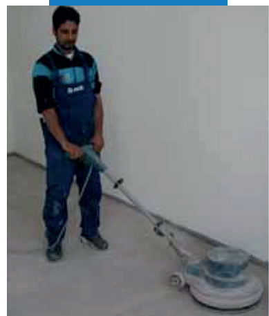
Подготовка основания шлифовальной машиной перед нанесением Ultraplan Eco (Ультраплан Эко)
