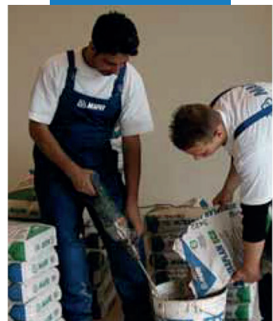
Смешивание Ultraplan Eco (Ультраплан Эко)
